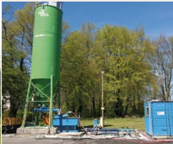
4 Hohlräume werden mit Beton verfüllt.
