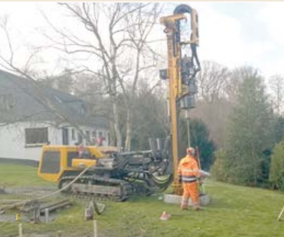
3 Bohrungen geben genaueren Aufschluss über Hohlräume.
