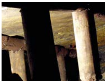
Holzstempel waren typische Stützelemente im historischen Bergbau.
