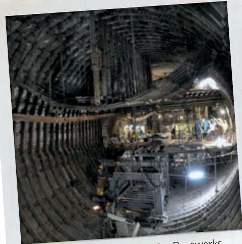
**Auf der 7. Sohle:** Mitarbeiter des Bergwerks setzen den Stahlbau am Füllort des Standorts Schacht 10.
