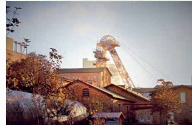
Konzernweites Projekt: Der Bergbaustandort Ibbenbüren stellt seine Wasserhaltung langfristig auf.
